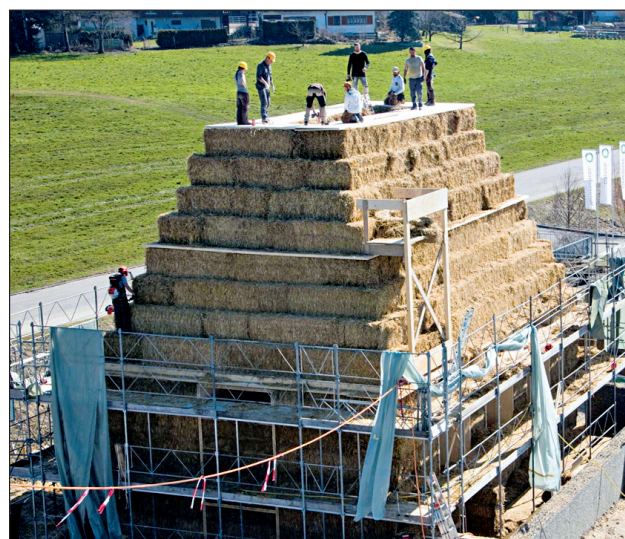
Die treppenartige Ausformung der lasttragenden Strohballenbauweise bleibt im Innenraum sichtbar. Foto: Werner Schmidt
